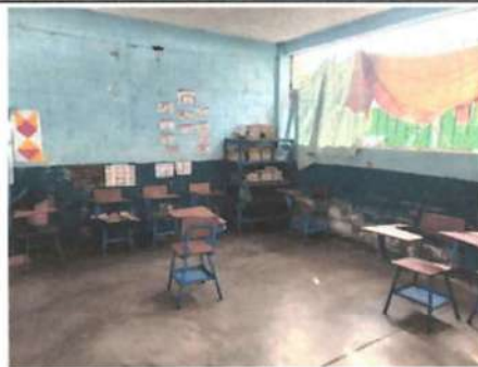
Foto 2: Preparación de la superficie y aplicación de pintura a dos manos, en paredes interiores y exteriores del establecimiento.
