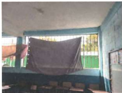
Foto 1: Sustitución de ventanas; sistema de apertura: Corredizas, Perfiles color blanco estandar, Material del marco: PVC Material de la ventana: Vidrio, sellado perimetral.
